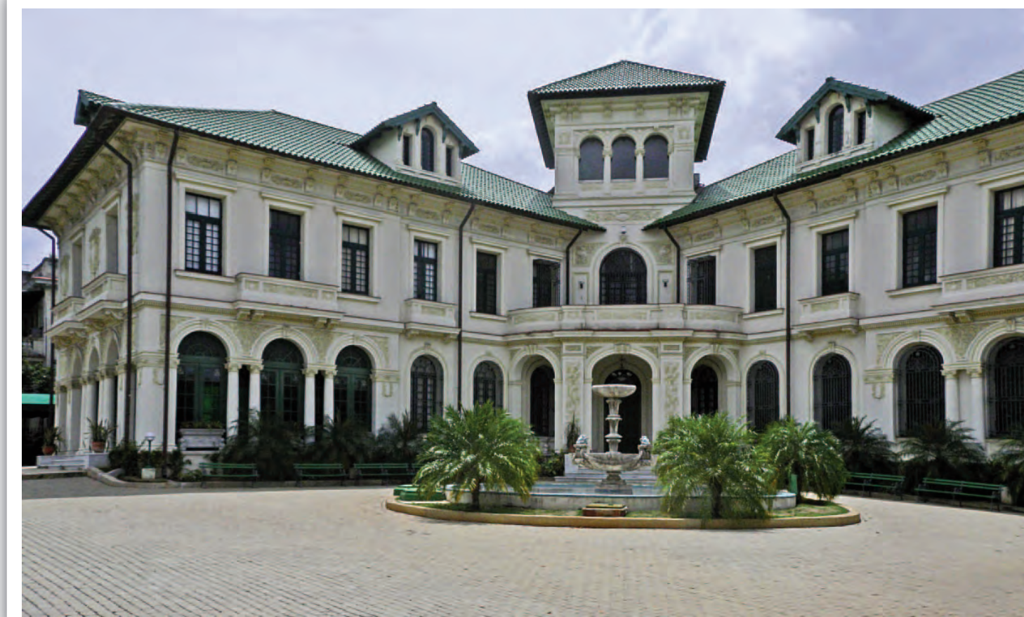
Edificio del Colegio Trelles en 23 y B.
