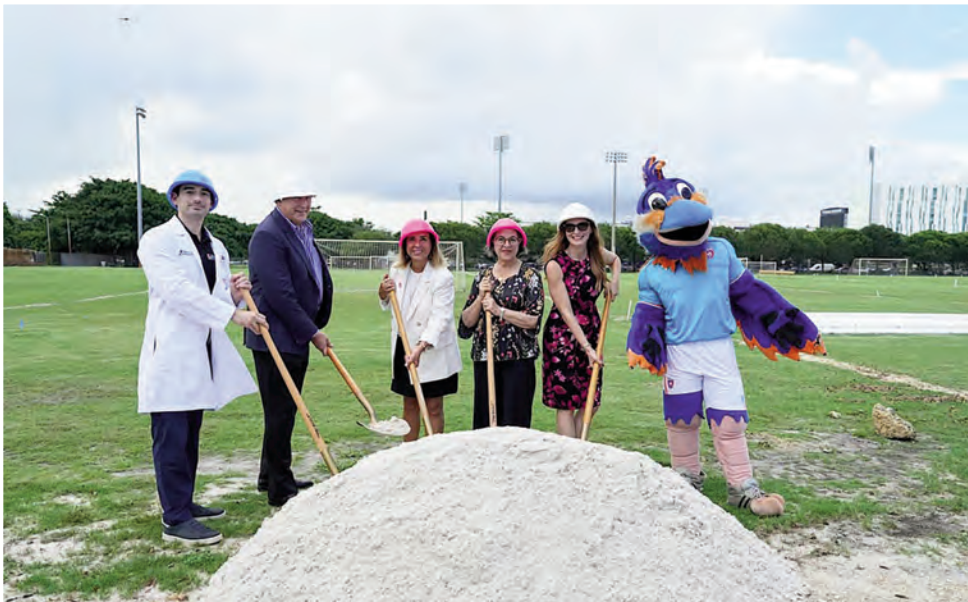
La alcaldesa Daniella Levine Cava encabezó el grupo que dio inicio a las obras de ampliación de las canchas.
