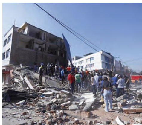
En algunas zonas de las ciudades de Pereira y Manizales, los edificios se vinieron al suelo.
