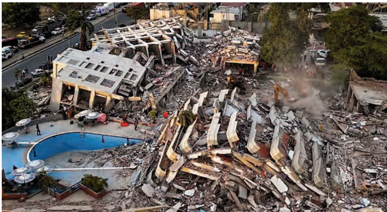
Las labores de remoción de escombros avanzan lentamente debido a la falta de maquinaria pesada necesaria para las operaciones de rescate en la zona de La Guaira.
