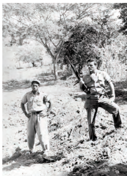
Frank Sturgis (Fiorini) sobre la zanja tapada con tierra. Luego fue uno de los 5 plomeros de Watergate.
