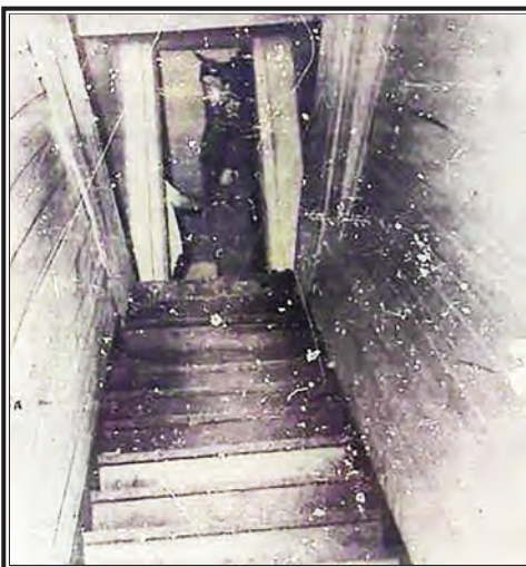
La escalera por donde huyeron los atacantes después del atentado.
