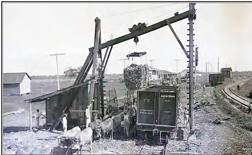
Carreta de bueyes descargando en la Grúa.
