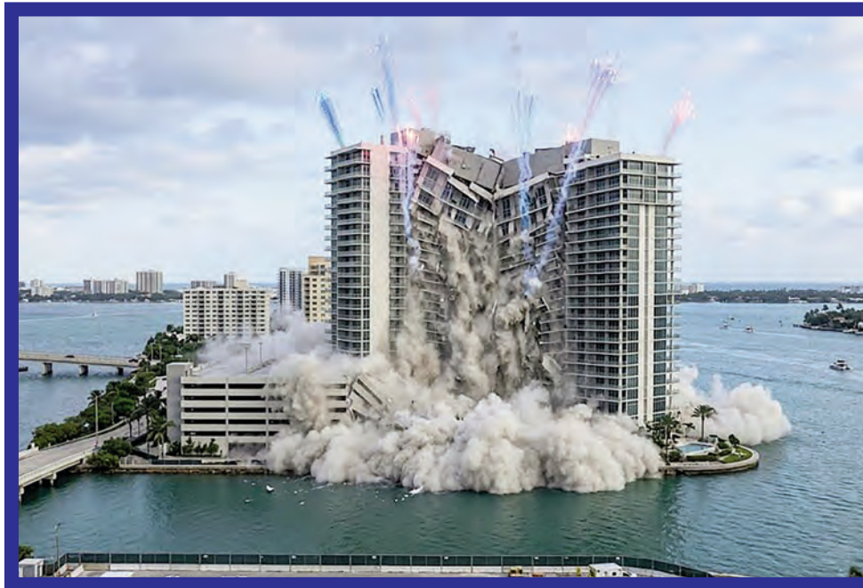
Hacia mucho tiempo no se observaba en Miami una demolición de tan grande calibre técnico.
