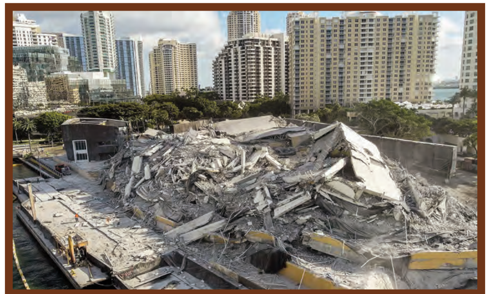
Un montón de escombros fue lo que quedó de la gigantesca edificación.
