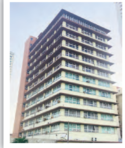
Edificio del Retiro Social del Colegio de Ingenieros en 17 y O, Eugenio Batista y Adolfo Arellano en 1957.
