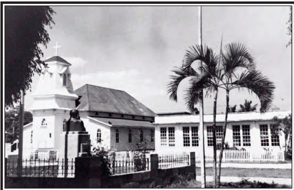
Iglesia y Centro Escolar de Preston.
