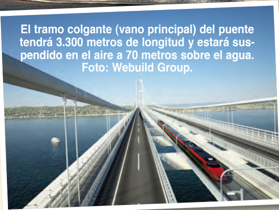
Cada una de las dos torres de soporte, que sostendrán el tramo colgante del puente, tendrán 399 metros de altura. Foto: Webuild Group.
