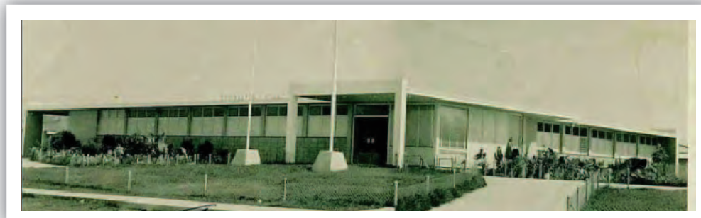
Edificio de la ONDI en Nuevitas, Camagüey.
