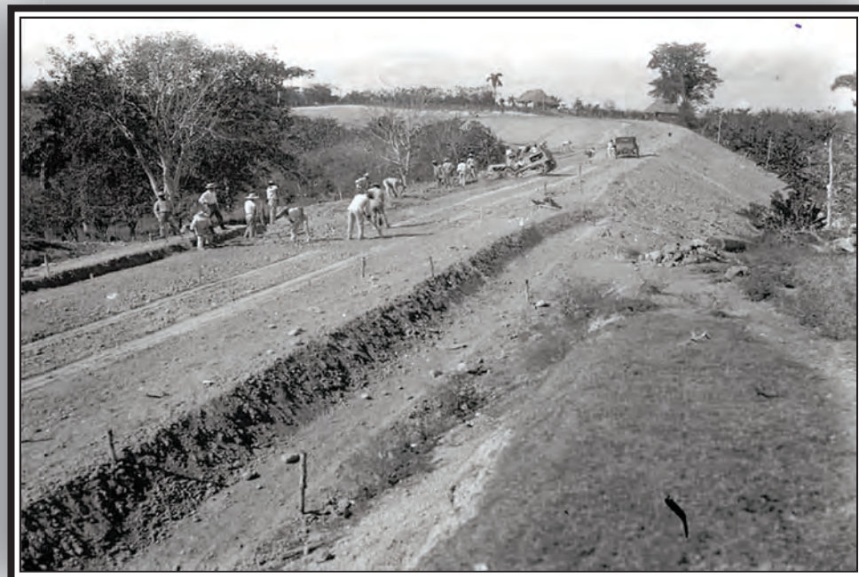
Obreros haciendo el movimiento de tierra.
