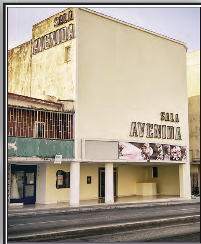
Teatro Avenida Ave. 41 #5614.
