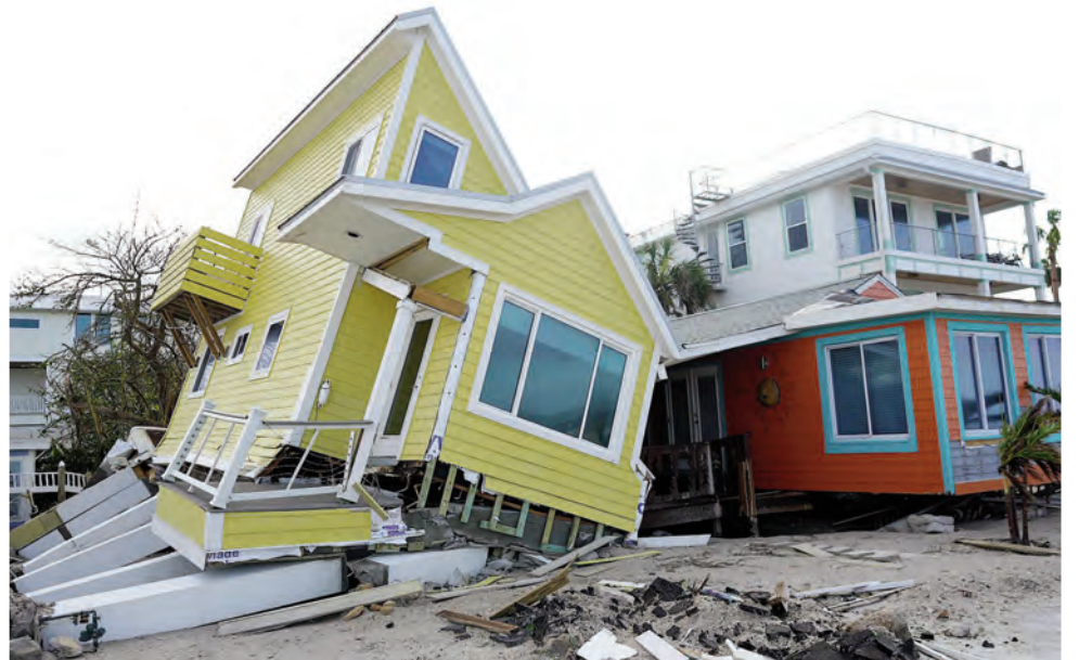
Los fuertes vientos echaron abajo la estructura de esta vivienda.
