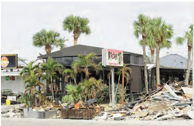
Numerosos comercios sufrieron destrozos en sus estructuras.
