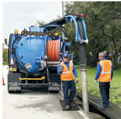
Brigadas locales destaparon las alcantarillas antes de que el huracán Milton tocara tierra cerca de Siesta Key, Florida, como tormenta de categoría 3.
