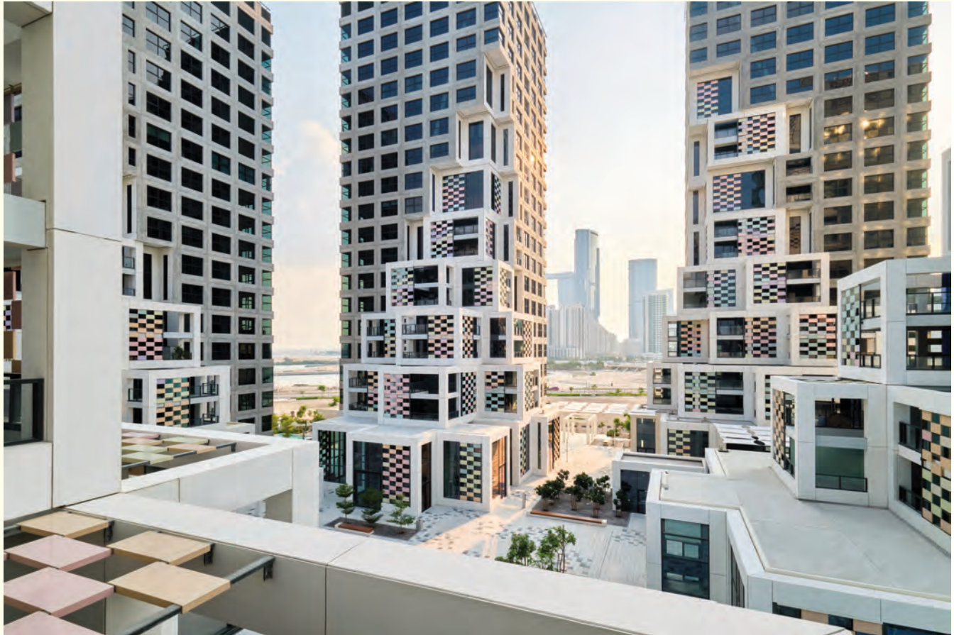
Edificios Pixel, parte baja del complejo. Foto MVRDV-Jon Wallis.
