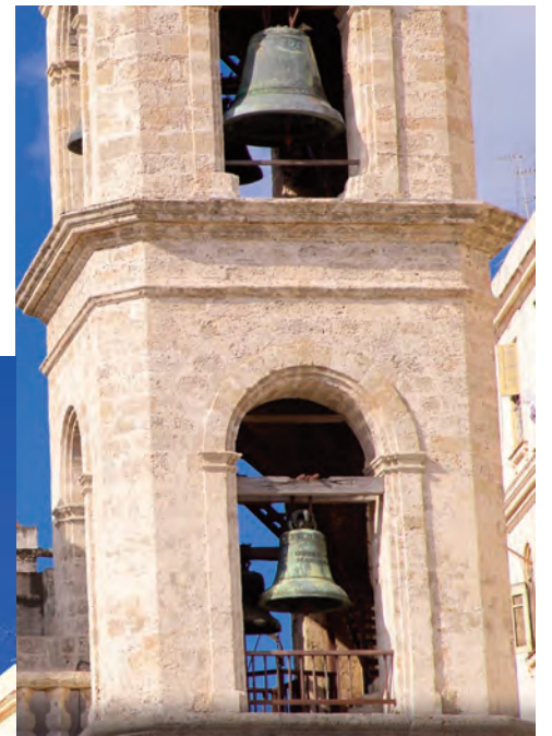
Hacia el lado izquierdo de la torre derecha...
