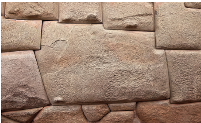
Piedra de los doce ángulos (centro) en la calle.
