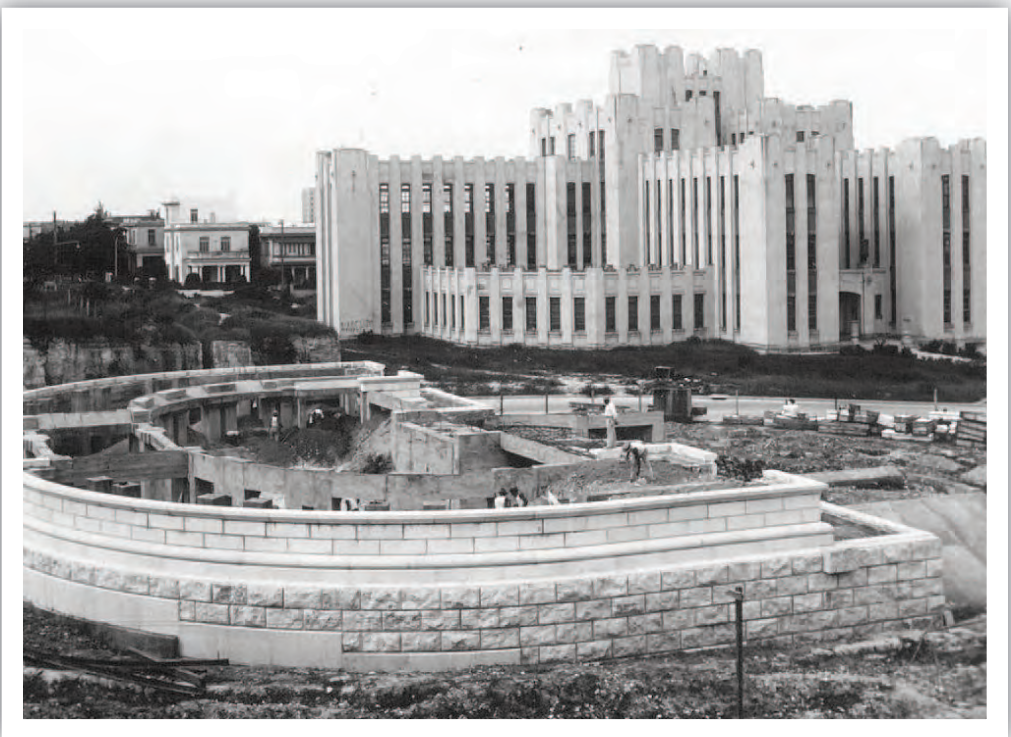
Hospital Infantil en 1934 y el monumento a José M. Gómez en construcción.
