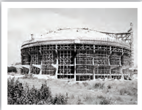
El Coliseo en construcción.
