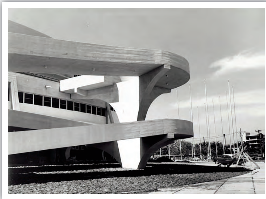
Las rampas de entrada y salida.
