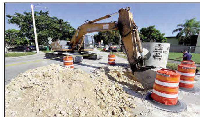
Tubería de gran tamaño se está montando para evitar futuras inundaciones.
