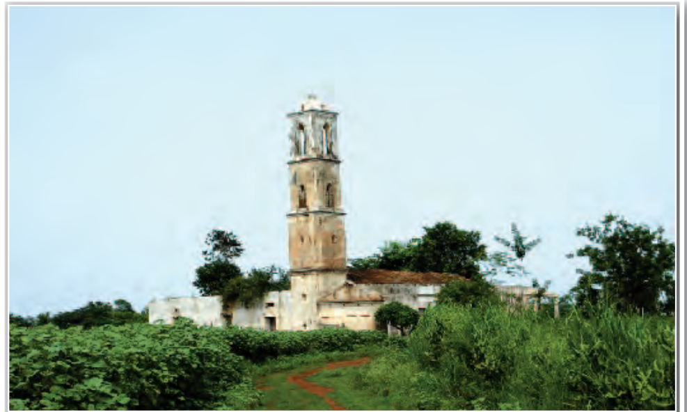
Ingenio "Dolores", fue fundado en 1823 y fue destruido por un incendio ocurrido en su casa de calderas, que estaba emplazada en el cuerpo central del edificio. En su extremo izquierdo se encontraban los molinos o trapiches y en el derecho la torre de observación, para la vigilancia de los esclavos que laboraban en los campos de caña.
