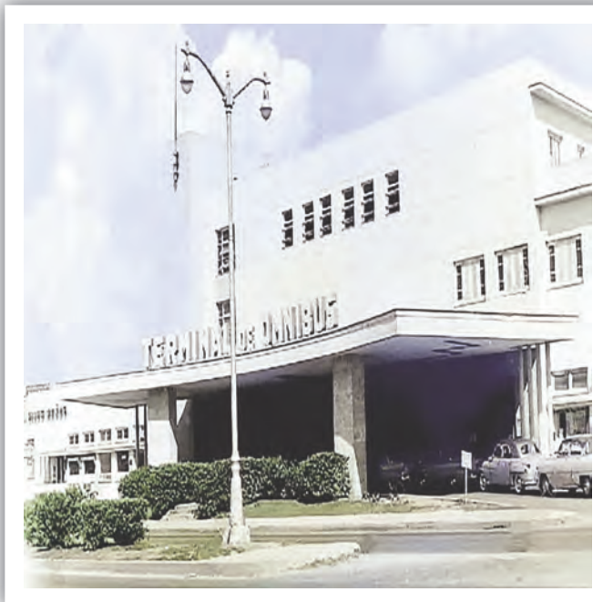
Foto del Edificio de la Terminal de Ómnibus.
