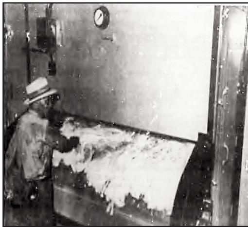
La fibra ha sido secada por el sol, pero eso no basta para una industrialización adecuada. Por eso se recurre a la acción de esta secadora eléctrica que deshidrata hasta el límite los finos hilos vegetales.
