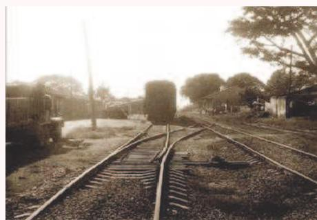
La materia prima se transportaba por ferrocarril. Disponía de una racha de 4 locomotoras con 120 carros de acero de 30 toneladas descarga lateral, y 60 km de ferrocarril de vía ancha.
